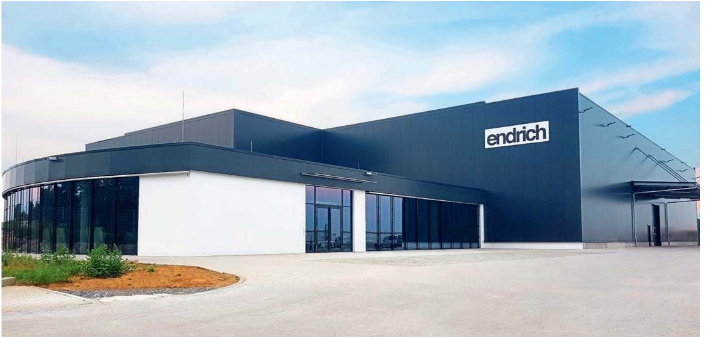
1 | Neubau: Logistikzentrum von Endrich in Nagold
